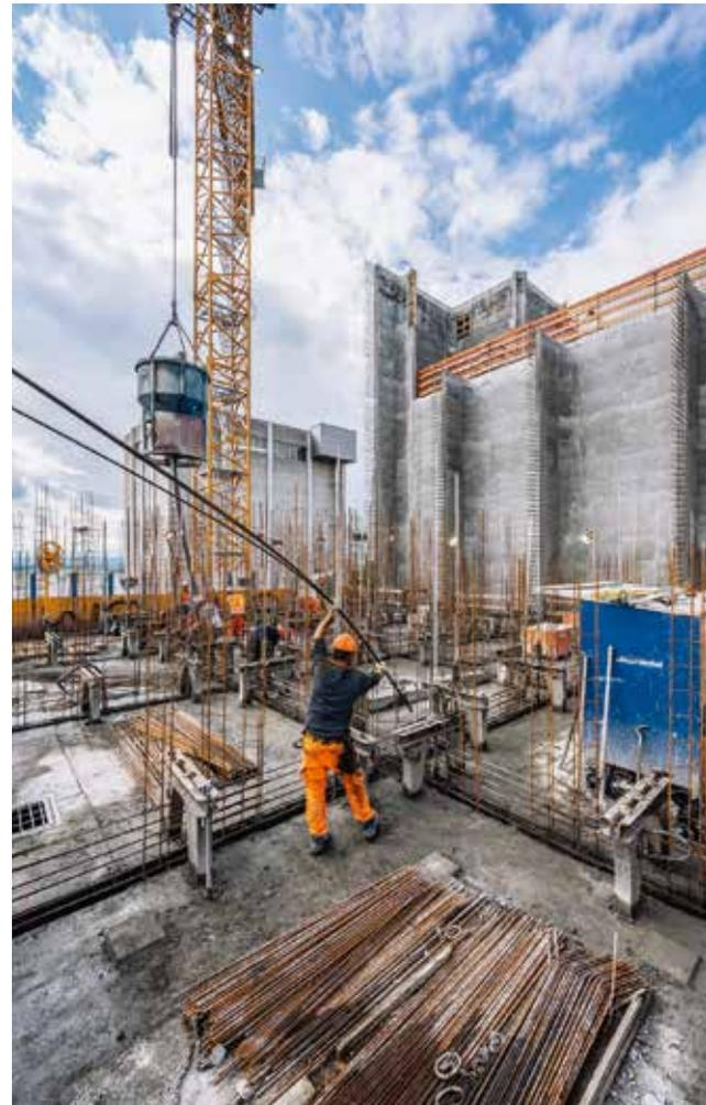
Aus dem Untergeschoss sind die Einlauftrichter sichtbar. Betoniert wurden sie durch den Silo-turm mit einer vorgefertigten Metallschalung.
