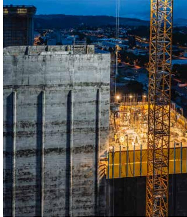
Armieren und Betonieren auf der Plattform in über 54 Metern Höhe (Stand: 10. Juni 2020)
